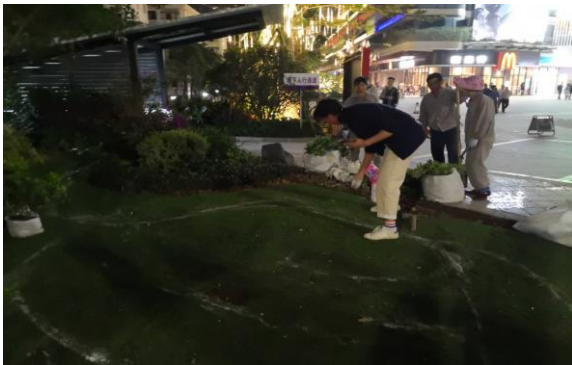
园林学生进行亮点工程施工放线
